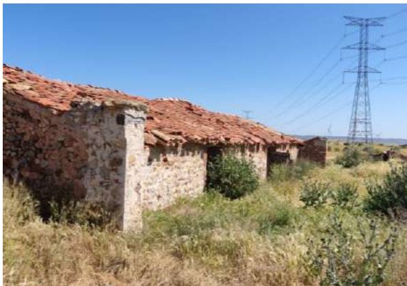
Fotografía 2. Casa en ruinas en el entorno de los parques eólicos.
