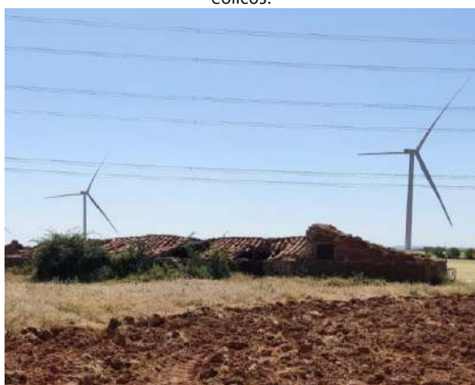
Fotografía 4. Casa en ruinas en el entorno de los parques eólicos.
