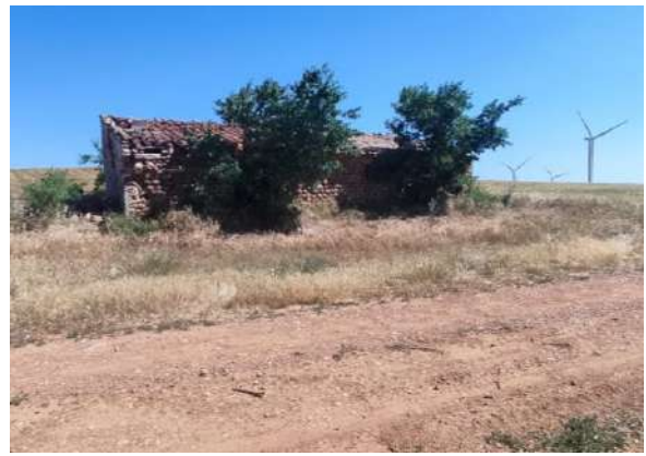
Fotografía 3. Casa en ruinas en el entorno de los parques eólicos.
