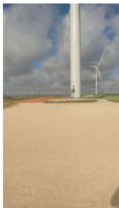
Fotografía 1. Procesos erosivos en el talud del vial del aerogenerador LCO1-01.
