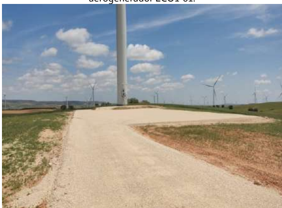
Fotografía 3. Estado de los taludes, caminos y cunetas del aerogenerador LCO1-03.
