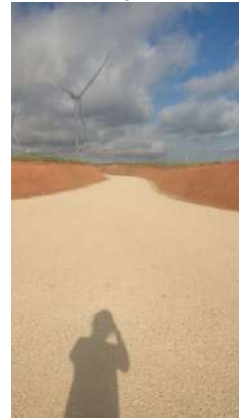
Fotografía 8. Estado de los taludes, caminos y cunetas entre los viales de acceso de LCO1-01 y LCO1-02.
